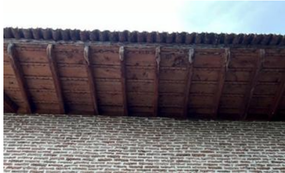
تصاویر ۱۰-۱۱) کنسول پوشش بام و لمبه کوبی چوبی، دندان‌موشی (مأخذ: نسترن جلالی مقدم)
