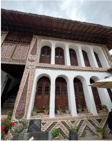
تصاویر ۱۰-۱۱) کنسول پوشش بام و لمبه کوبی چوبی، دندان‌موشی (مأخذ: نسترن جلالی مقدم)
